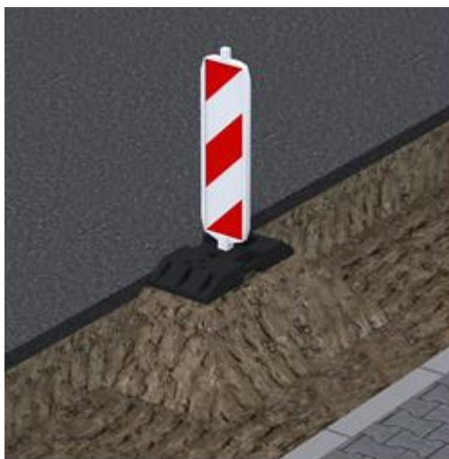
Слика 31. Вертикална запрека постављена у ископу, на постољу формираном од земље
