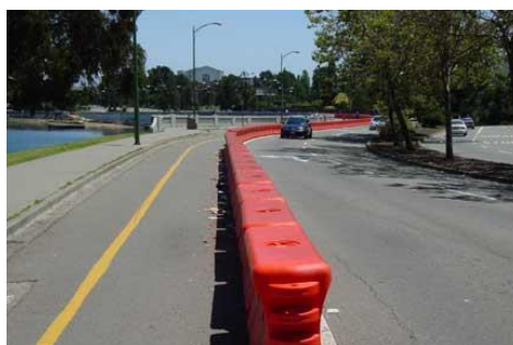
VII-6.1 Пластичне монтажне раздвајајуће ограде пуњене водом и ојачане кабловима
