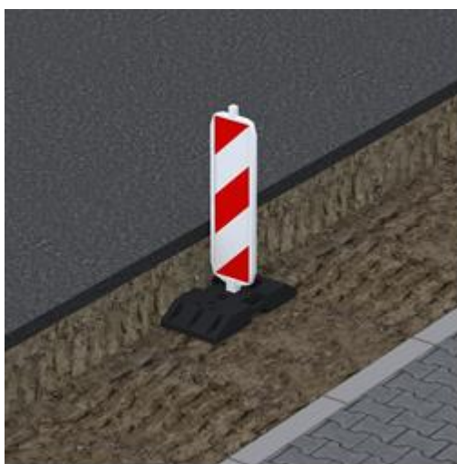
Слика 32. Вертикална запрека постављена у самом ископу
