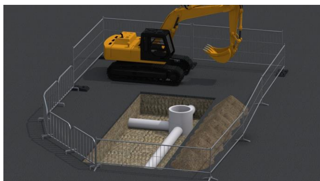
Слика 96. Жичане ограде без универзалних постоља
