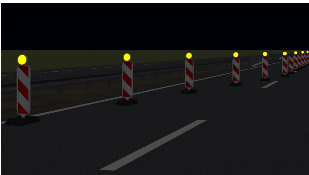
Слика 55. Исправна употреба жутих светала упозорења СУ-1 у континуалном режиму
